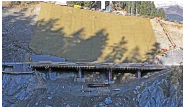
construcziun da betun dalla punt finida
